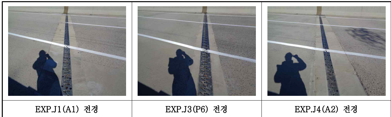
【사진 24.3.16】 신축이음장치 전경
