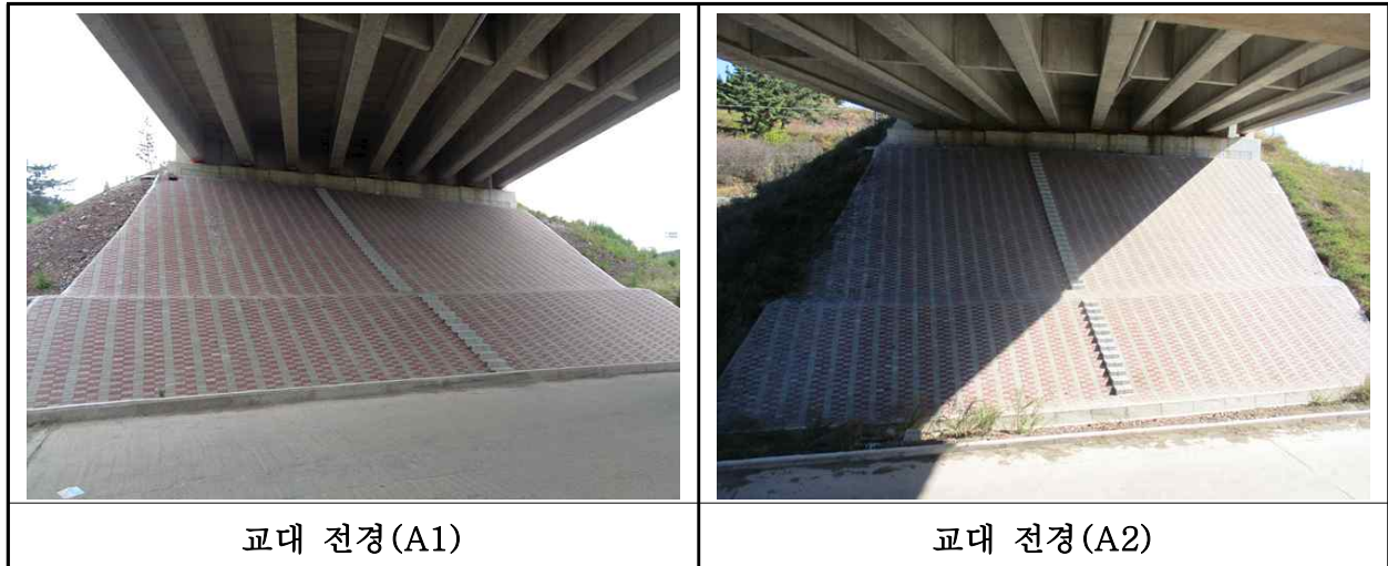
【사진 24.3.8】 교대 전경
