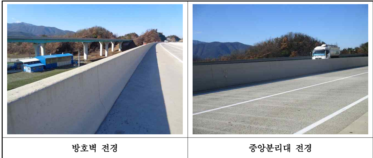
【사진 24.3.23】 방호벽 및 중앙분리대 전경
