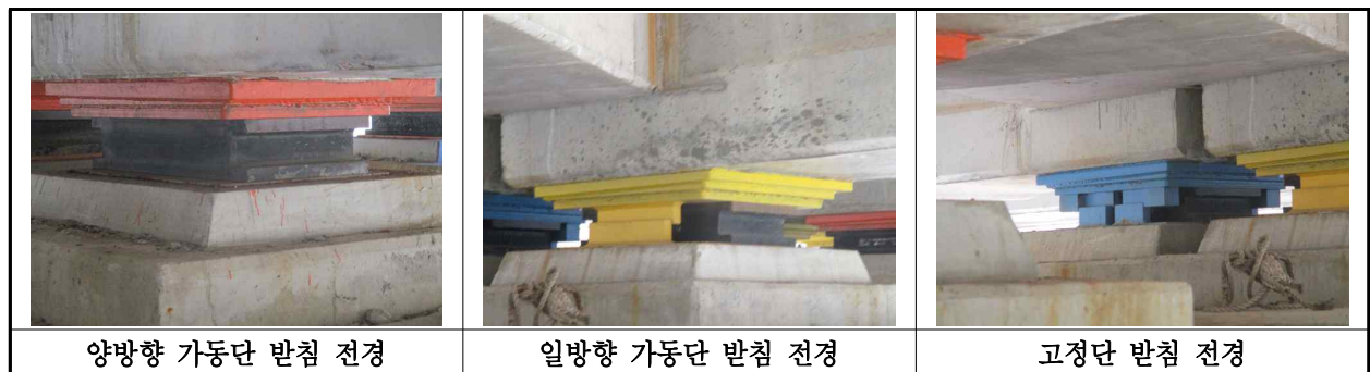
【사진 24.3.12】 교량받침 전경
