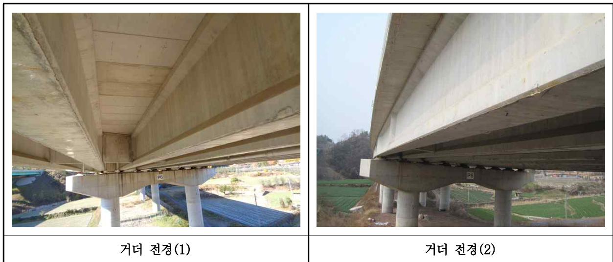
【사진 24.3.4】 거더 전경
