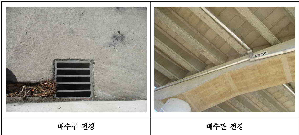
【사진 24.3.21】 배수시설 전경
