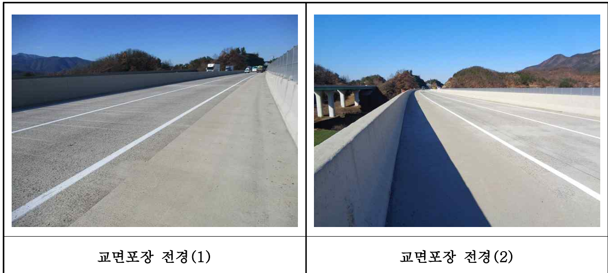
【사진 24.3.19】 교면포장 전경
