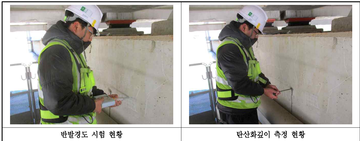
【사진 24.4.1】 콘크리트 내구성조사 현황
