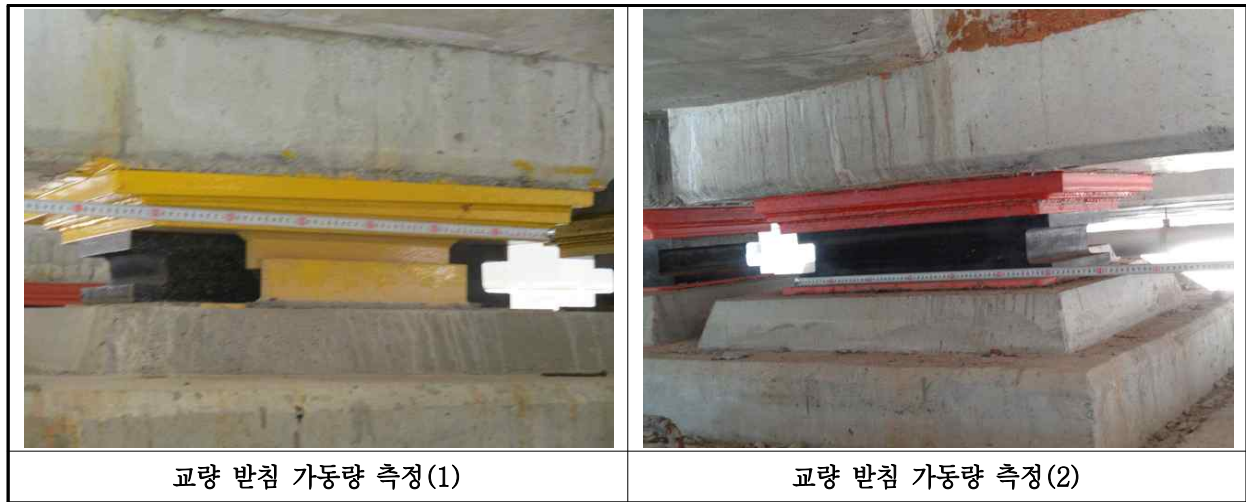
【사진 24.3.15】 교량받침 이동량 측정
